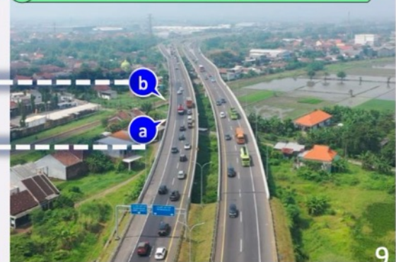
F Tampak Atas Pelebaran Jalan pada Area At Grade
