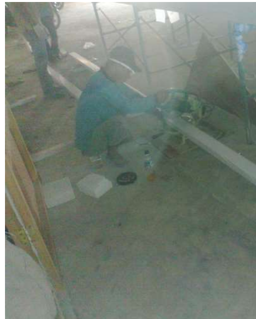
Fabrikasi mullion di workshop
