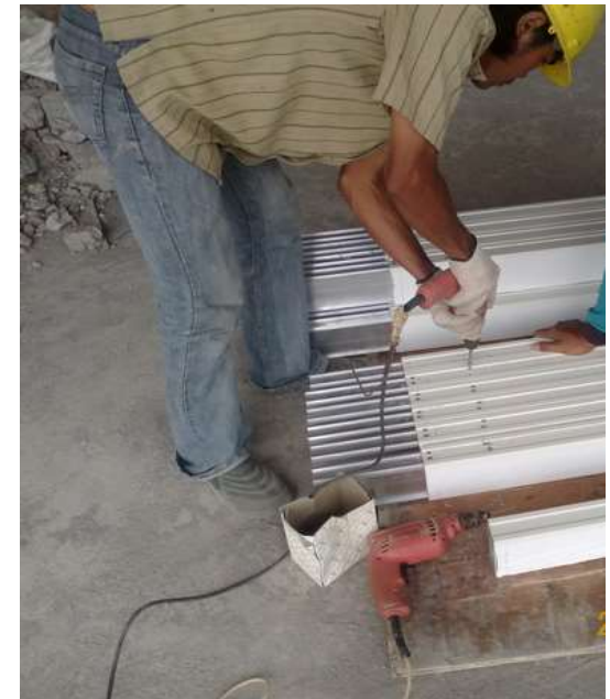
Pemasangan join sleeve
